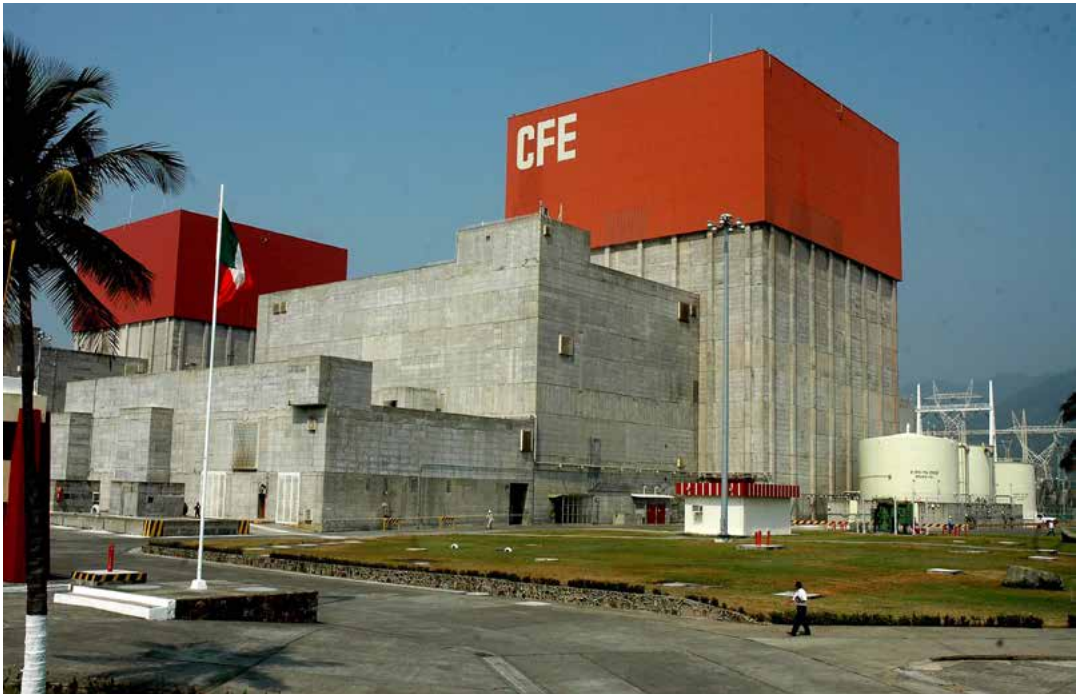
La Central Nuclear de Laguna Verde es la única central nuclear de generación eléctrica de México. Foto AH-IPN.
